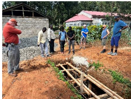
ABR Under Construction
